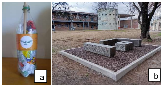
Figura 1. a) Proceso de compactación de una ecobotella de 1.5 litros usando una vara que llegue al fondo de la botella. b) Estación sustentable construida con 340 ecobotellas y 0,35 m 3 de vidrio molido.
